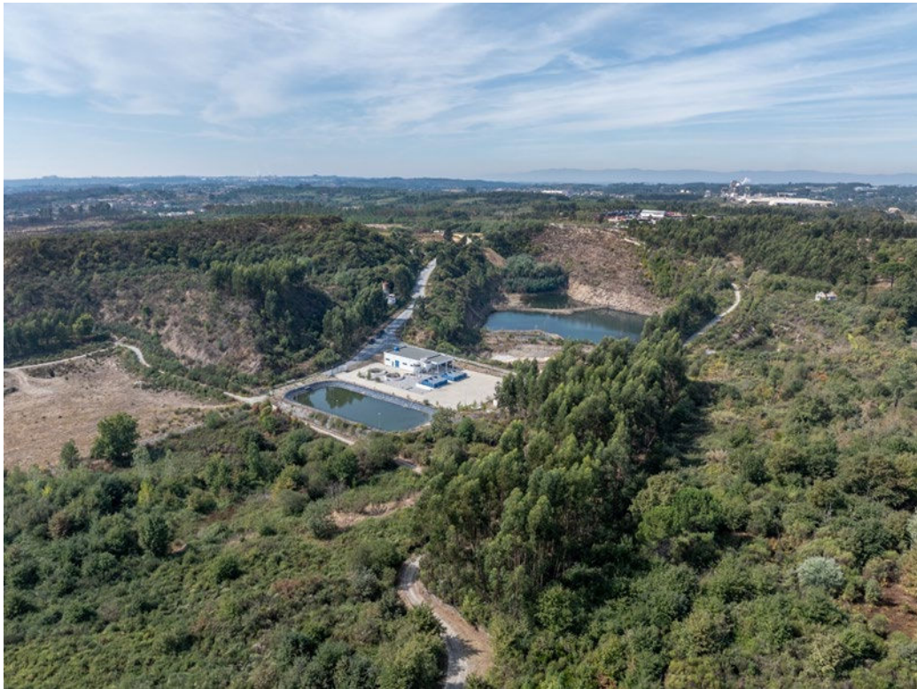
ETAM Barragem Nova da Urgeiriça
