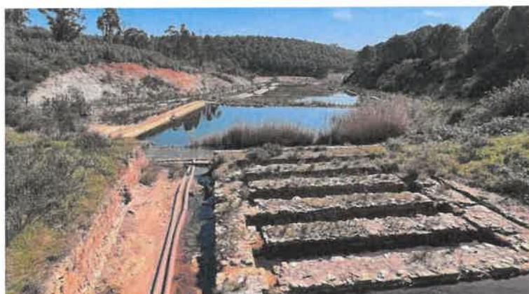
Figura 5.18. Lagoas do sistema de tratamento passivo de águas ácidas na área mineira de Lousal
