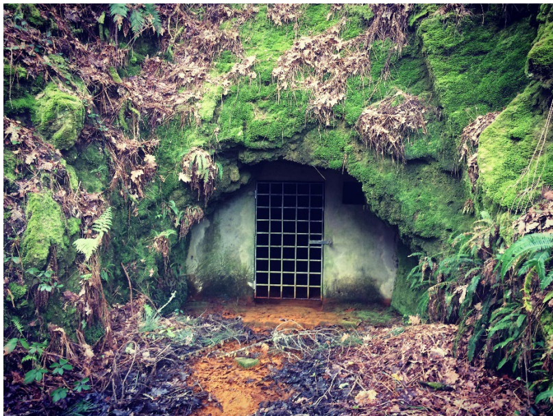
Figura 12 – Localização (imagem superior) e precipitados (imagem inferior) de drenagem ácida de mina na antiga área mineira de Covas
