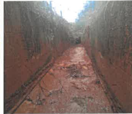
À esquerda, remoção das lamas depositadas no canal; À direita o canal já se encontra limpo
