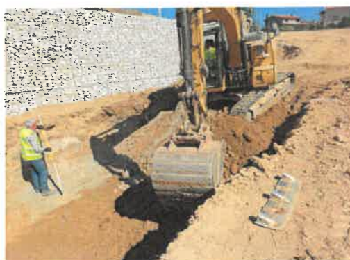
Colocação de telas no tratamento passivo I, à esquerda; Escavação para implantação do tanque em betão armado, à direita
