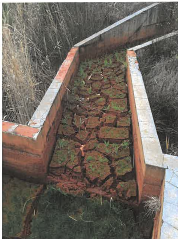
Precipitados de drenagem ácida de mina na antiga área mineira de Jales
