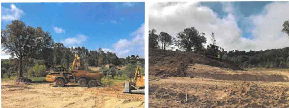
Movimentação de terras, escavação dos materiais de escombreira de minério
