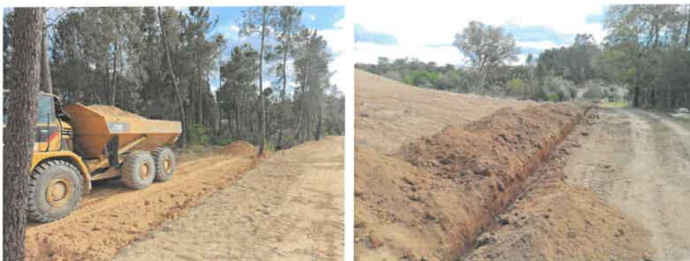
Alargamento de caminhos e execução dos sistemas de drenagem
