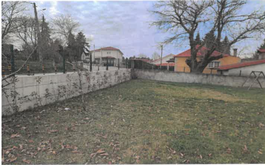
Jardim e logradouro rehabilitado
