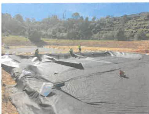
Colocação de telas no tratamento passivo I, à esquerda; Escavação para implantação do tanque em betão armado, à direita
