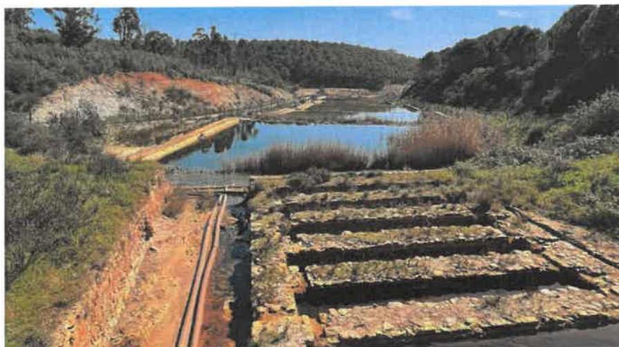
Lagoas do sistema de tratamento passivo de águas ácidas na área mineira de Lousal
