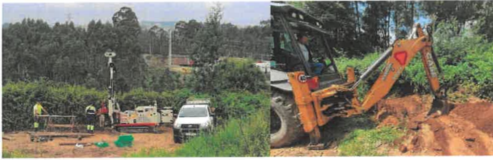
À esquerda, execução de sondagens geotécnicas; À direita, execução de poços de reconhecimento
