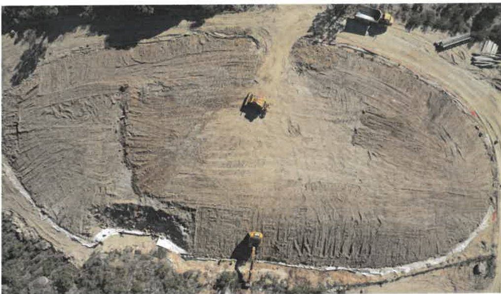
Fase final da modelação da célula de confinamento total na antiga Área Mineira de A-do-Cavalo
