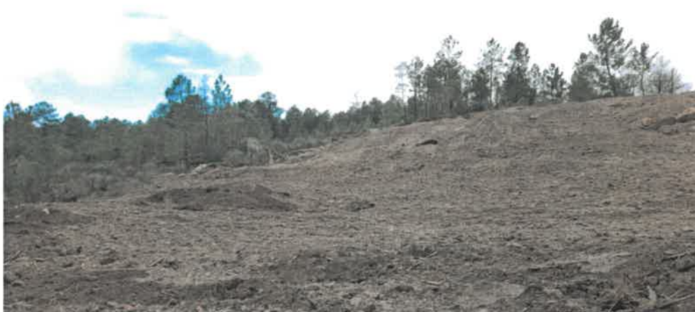
Espalhamento de terras de suporte ao coberto vegetal com processo sequencial de integração paisagística
