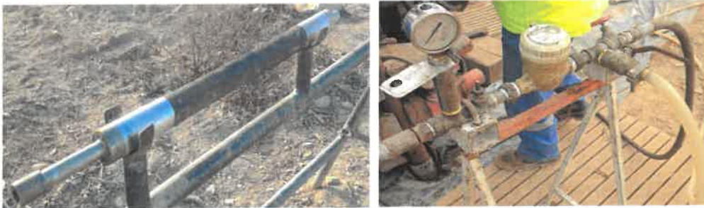
Obturador simples usado para isolamento da câmara de teste e pormenor do contador e manómetro de pressão
