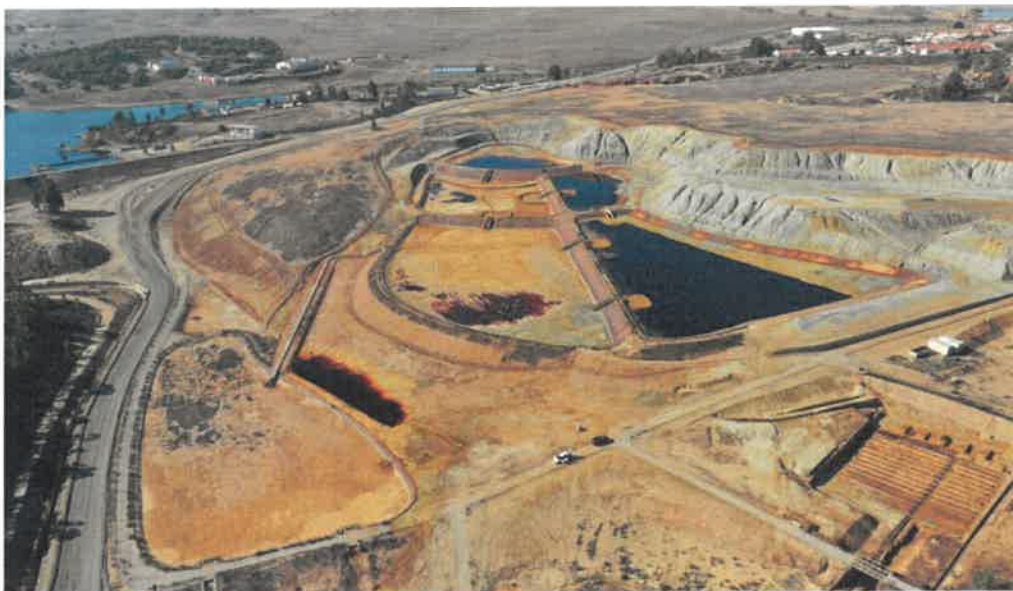
Fotografia aerea da antiga área mineira de Aljustrel, lagoas de decantação e evaporação
