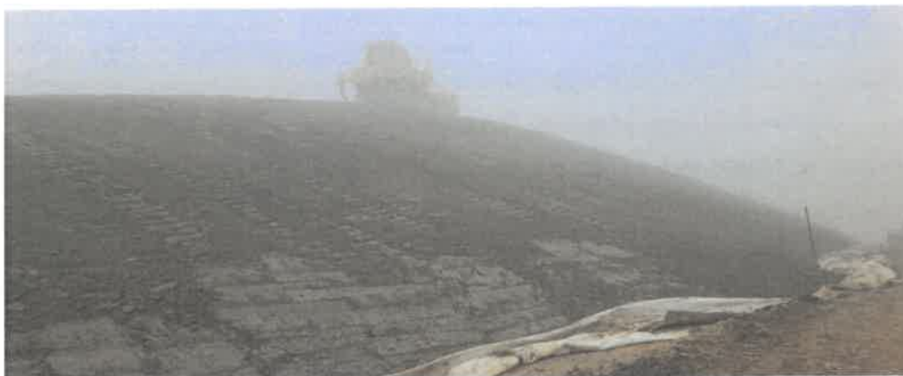
Colocação de camadas superiores de revestimento e confinamento (A-do-Cavalo)
