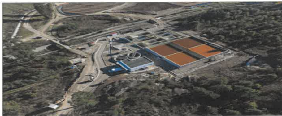
ETAM Barragem Nova da Urgeiriça
