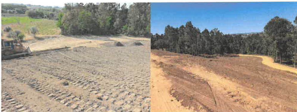
Espalhamento de terra vegetal
