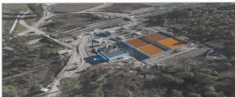
ETAM Barragem Nova da Urgeiriça
