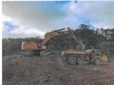
Movimentação de terras, remoção e transporte de escombros para confinamento
