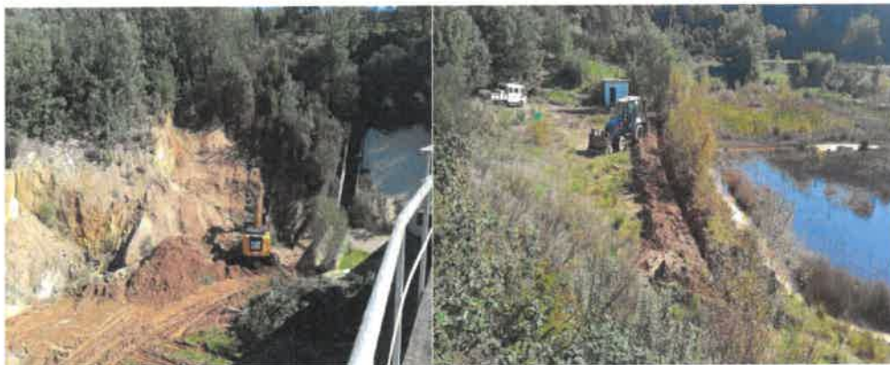
Desarborização e limpeza das chaminés à esquerda; Abertura mecânica de vala na periferia dos órgãos instalados para esvaziamento sequencial das lagoas, à direita
