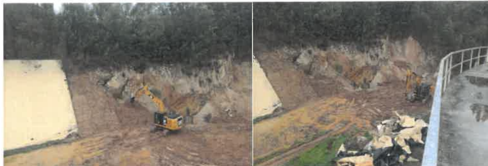
Regularização de taludes à esquerda; Remoção de telas e geotêxtil, à direita
