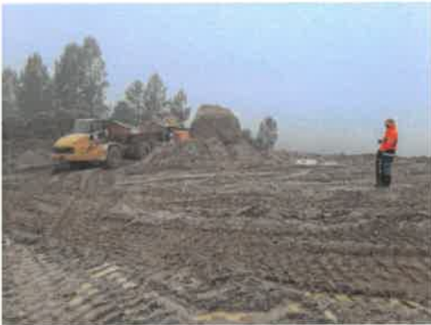
Operações de movimentação de terras e acompanhamento radiométrico
