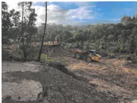
Movimentação de terras, remoção e transporte de escombros para confinamento
