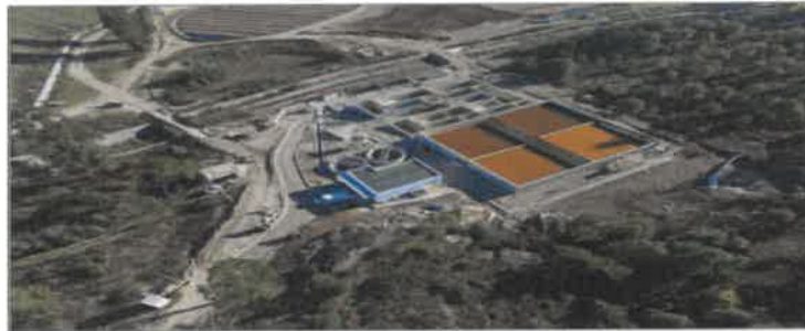
ETAM Barragem Nova da Urgeiriça
