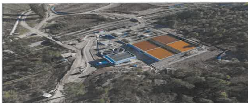
ETAM Barragem Nova da Urgeirica
