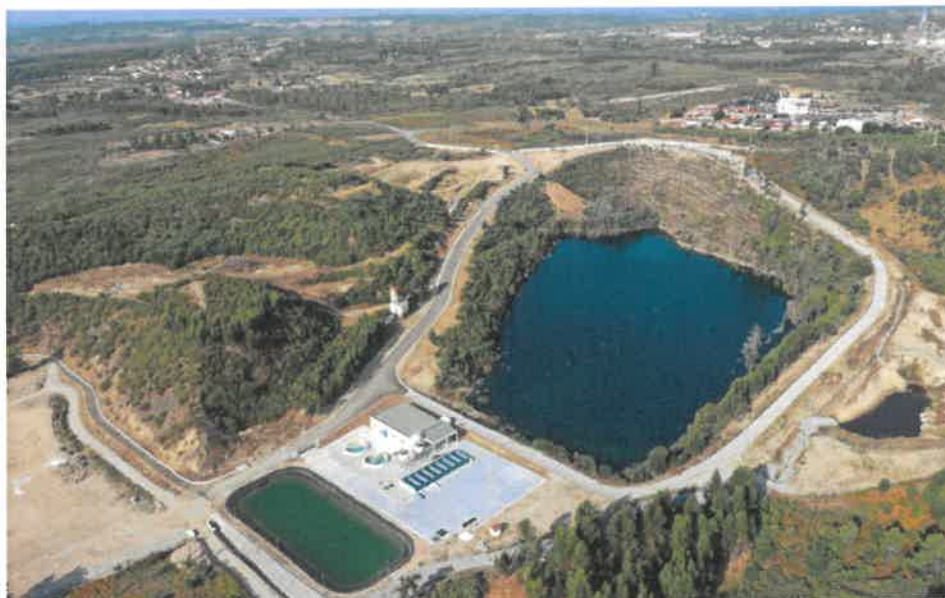
Aspeto geral da Fase 1 da intervenção na área mineira de Quinta do Bispo.
