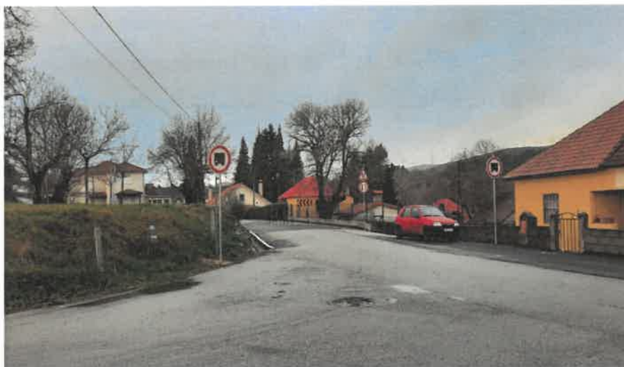
Troço da Estrada Municipal com o trânsito retomado após intervenção
