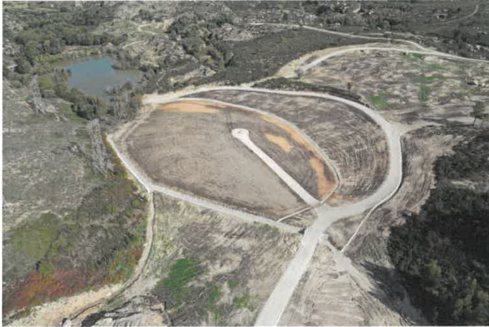
Vista aérea da área mineira de Ribeira do Bôco após conclusão dos trabalhos de remediação ambiental.
