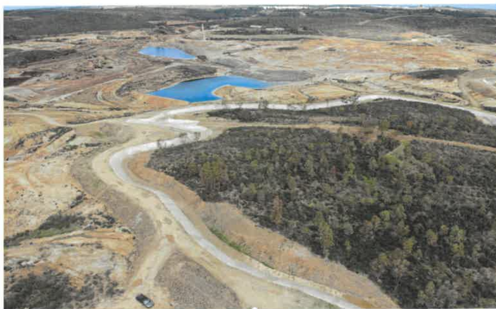
Recuperação do sistema de canais de recolha de água - margem esquerda – mina de São Domingos.
