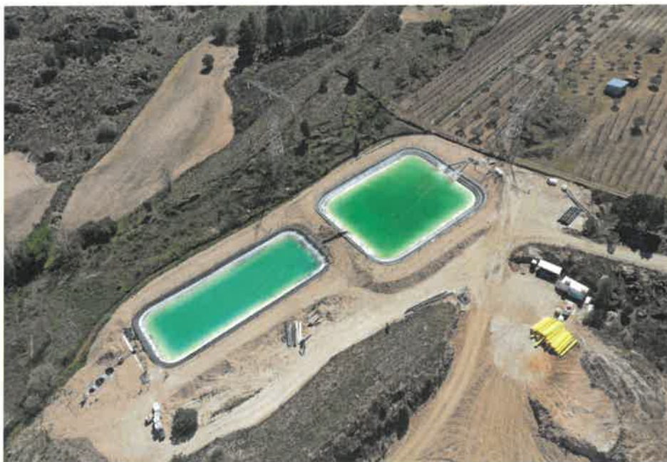
Fase final do esvaziamento e tratamento de água do céu aberto – mina de Mortórios
