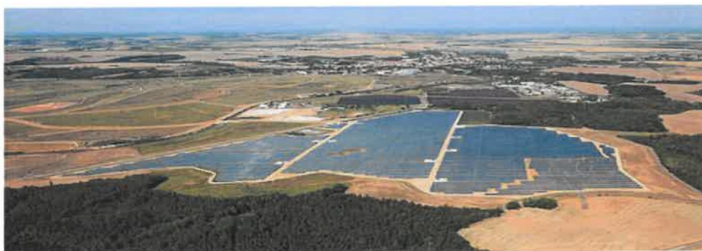
Solar Park Beerwalde, Ronneburg, 2012 ((Antiga mina de urânio))
