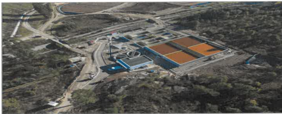
ETAM Barragem Nova da Urgeiriça
