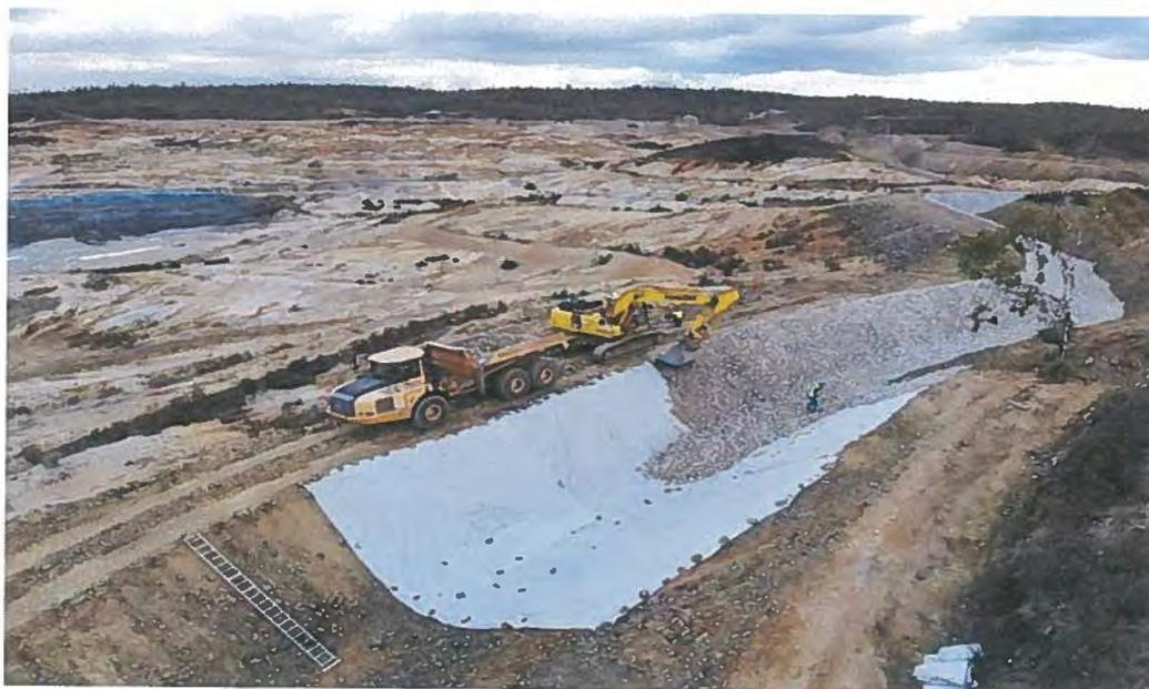
*Recuperação do sistema de canais de recolha águas – margem esquerda – mina de São Domingos.*
