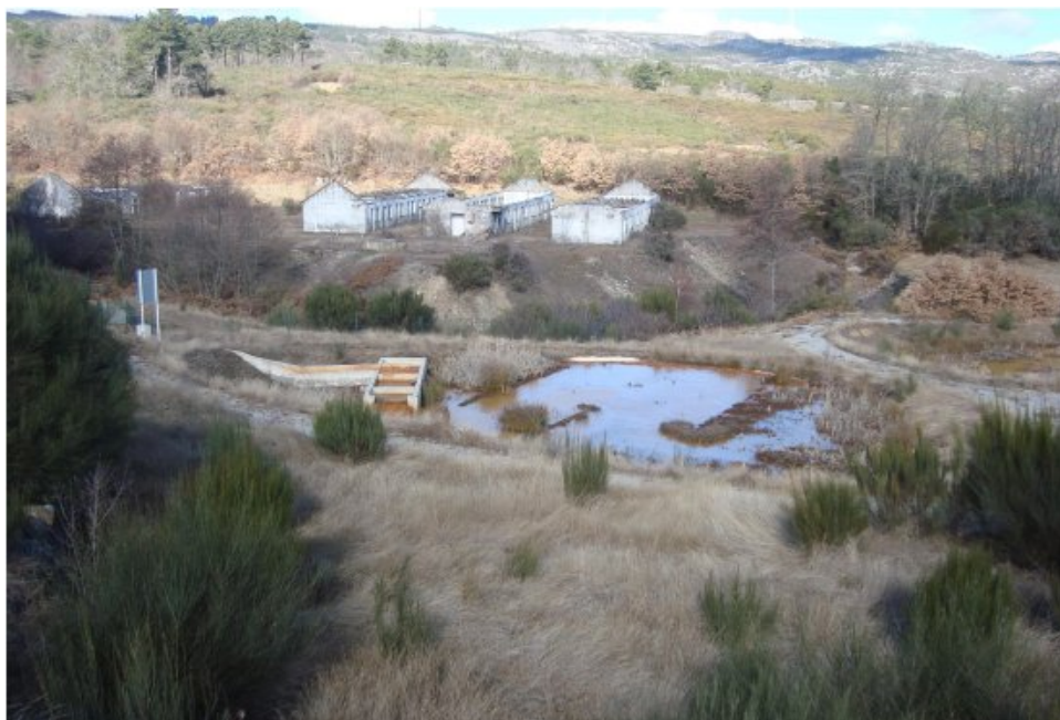
Imagem 6 – Vista do terreno onde foram instaladas as wetlands e os sistemas de monitorização de efluentes (Jales)
