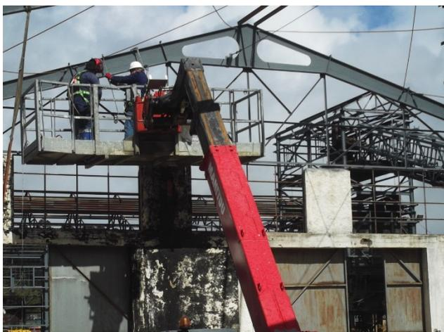
Execução de reforço na estrutura metálica de cobertura do edifício "Oficinas" (04.2018)
