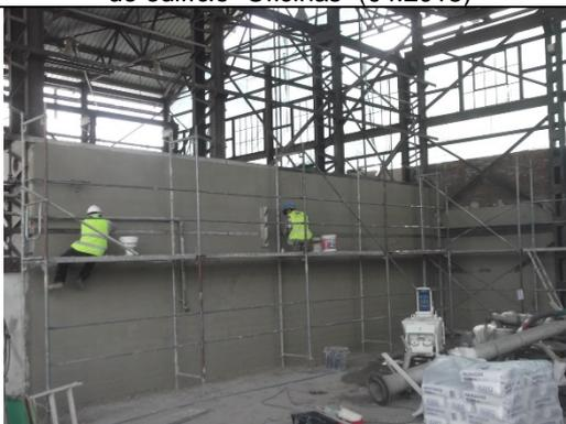
Execução de rebocos das alvenarias interiores do edifício "OTQ" (04.2018)
