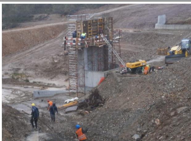
Trabalhos de montagem de armadura e cofragem (estrutura de entrada da BR1).
