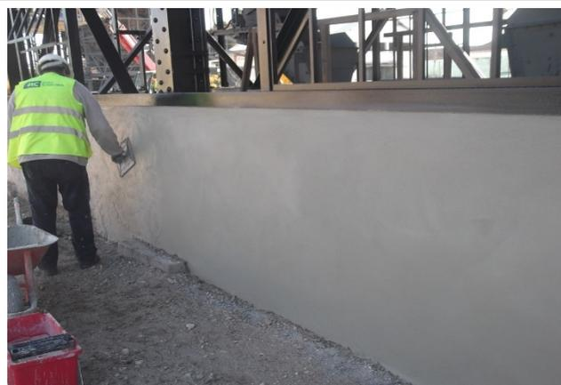
Execução de rebocos nos muretes do edifício "Passadiço" (02.2018)
