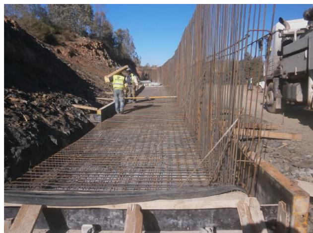
Trabalhos de montagem de armaduras (sapata e muro C1T7)
