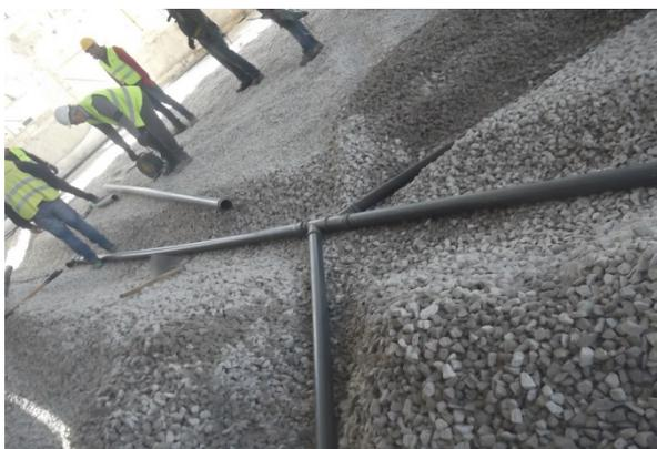
Execução de sistema de ventilação de pavimento no edifício "Oficinas" (05.2018)
