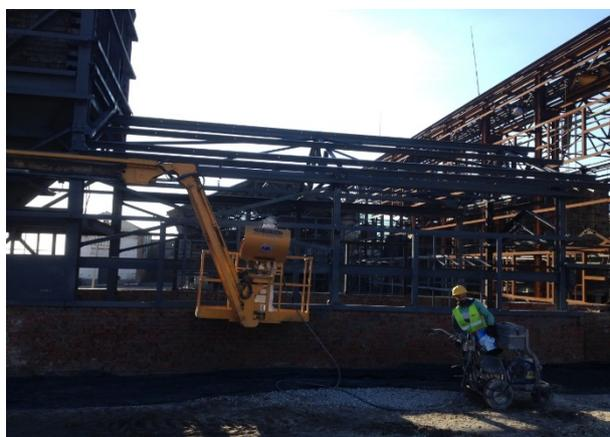
Tratamento e pintura da estrutura metálica do edifício "OTQ" (01.2018)
