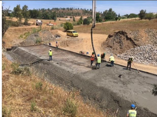
Trabalhos de betonagem (laje do descarregador lateral)
