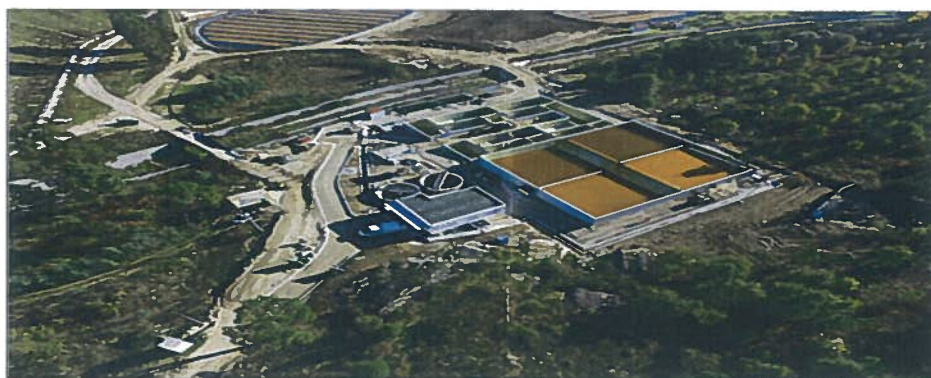
ETAM Barragem Nova da Urgeiriça
