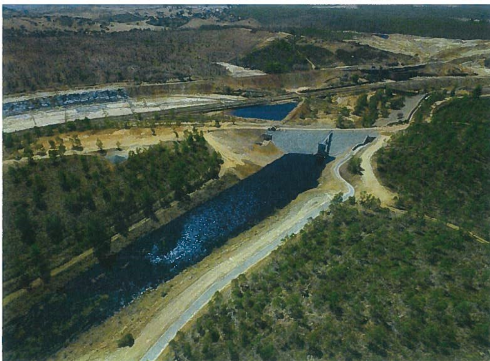
Vista aérea dos trabalhos de recuperação na antiga área mineira de S. Domingos – Fase 1
