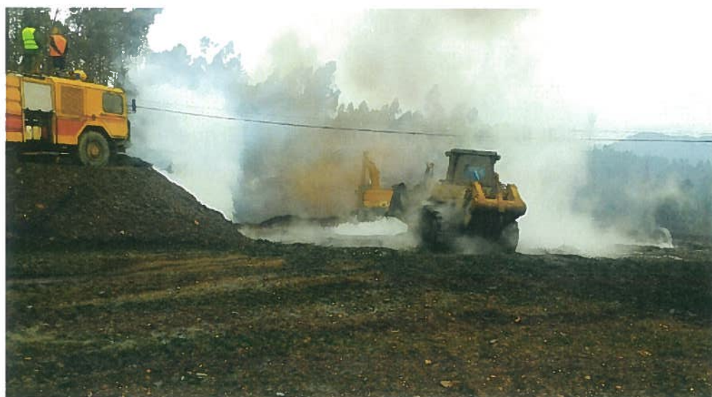
Mobilização e extinção do foco de combustão A3
