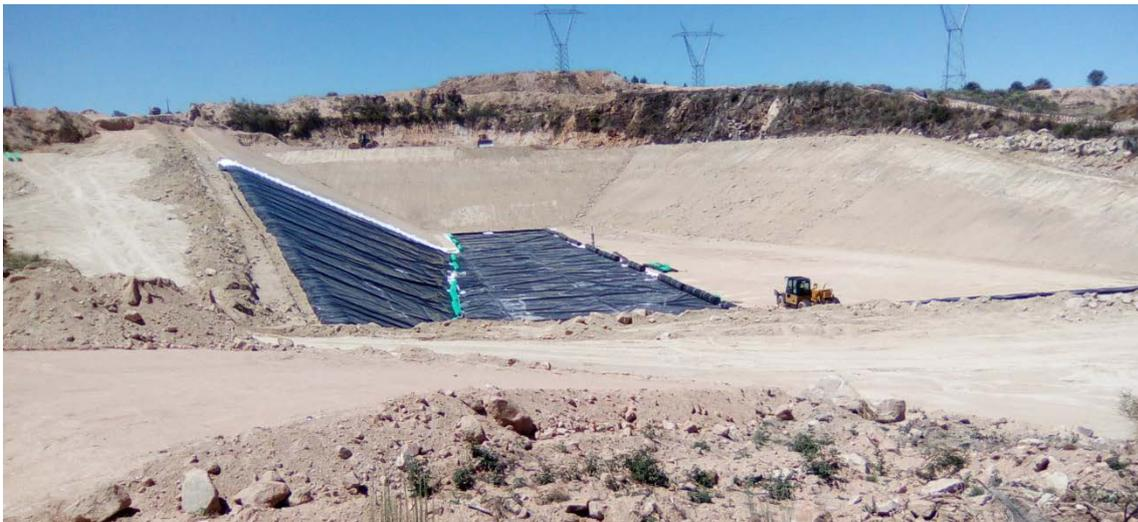
Área Mineira do Castelejo – execução do revestimento da base da célula de confinamento de CA2 com geomembrana PEAD.
