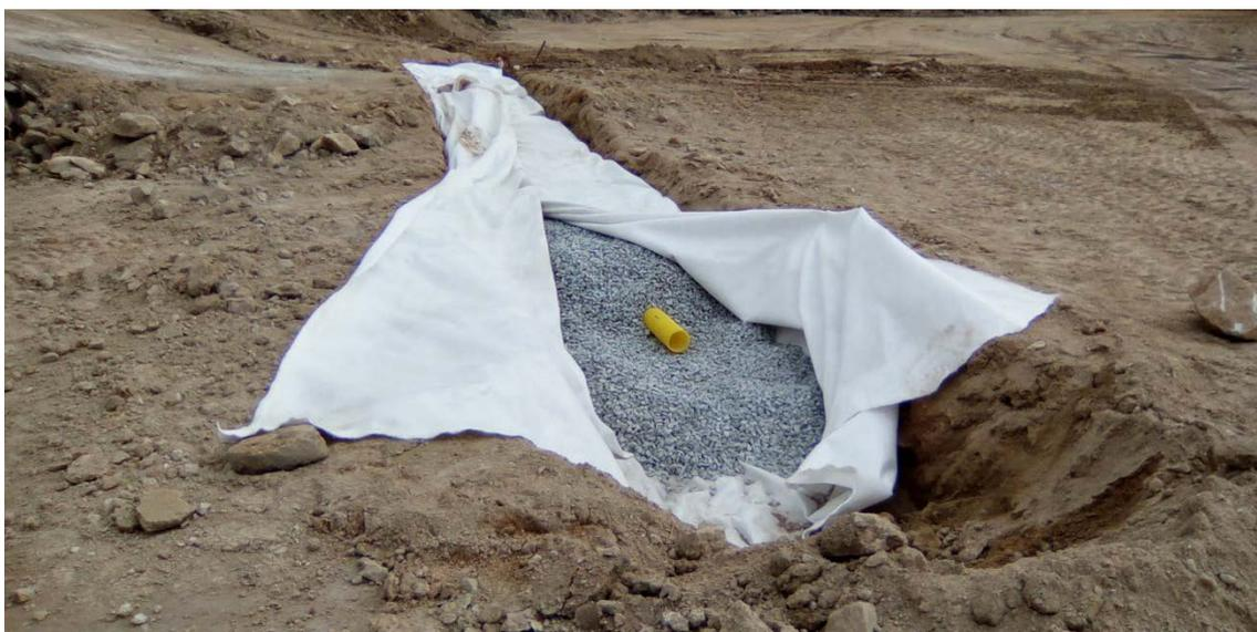
Área Mineira do Castelejo – dreno de águas profundas instalado a NE de CA2.
