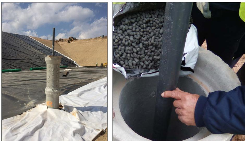
**Detalhes da instalação de um piezómetro no centro da corta para monitorização hidroquímica da base da célula de confinamento**
