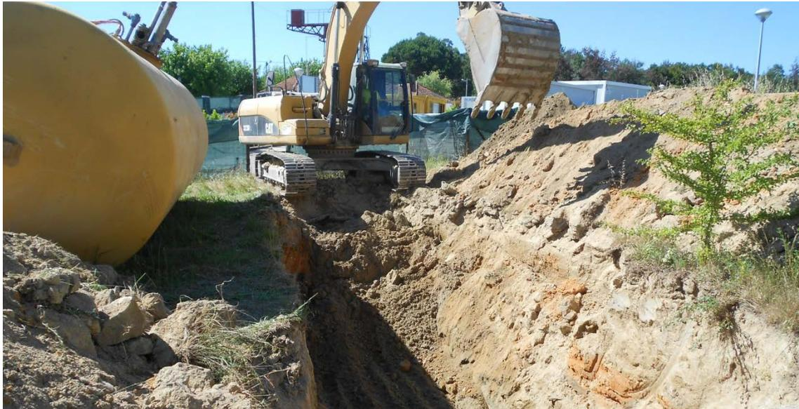
Escavação para colocação da fossa estanque associada à descontaminação de equipamentos.
